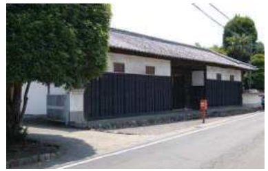
清水家旧主屋・長屋門 市登録有形文化財(建造物)
