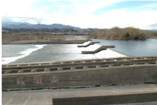
磯部頭首工 手前が魚道になっています
