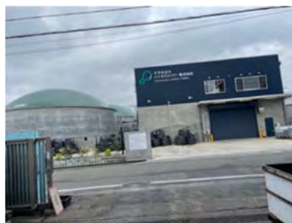
さがみはらバイオガスパワー株式会社
